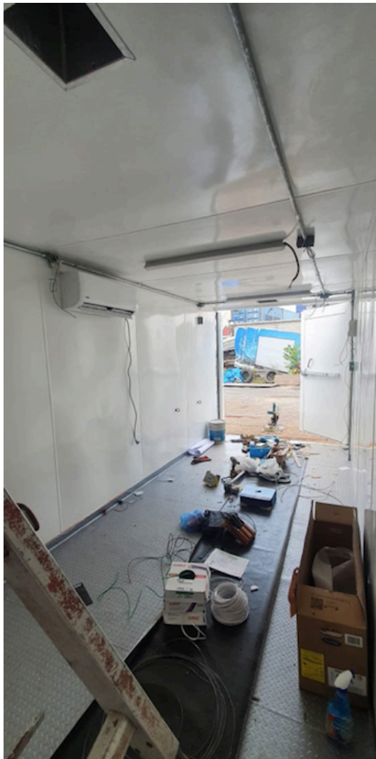
Figura 4. Fotos de los trabajos de instalación eléctrica al interior del contenedor que incluye interruptor general, centro de carga, iluminación, contactos y aire acondicionado.
