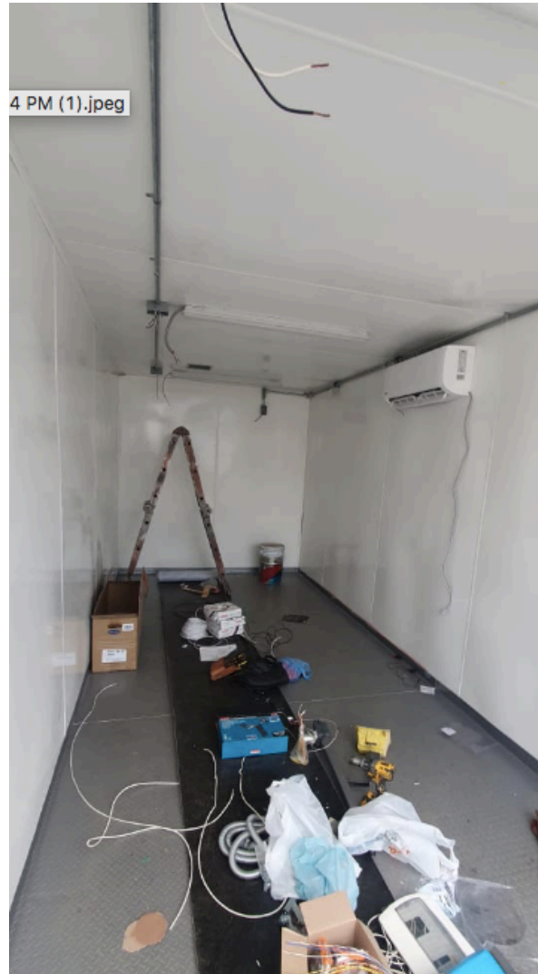
Figura 4. Fotos de los trabajos de instalación eléctrica al interior del contenedor que incluye interruptor general, centro de carga, iluminación, contactos y aire acondicionado.
