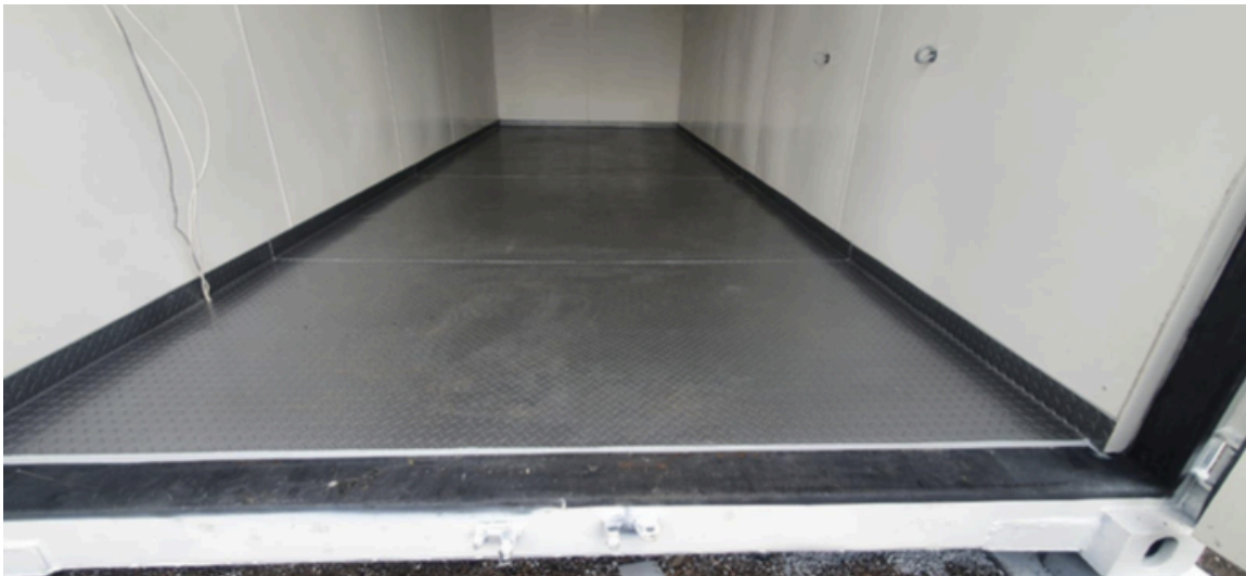
Figura 3. Fotos de los acabados del contenedor al día de hoy, en donde se muestra la aplicación del aislamiento, paredes, pisos y pintura exterior (4 manos de primer y 4 manos de pintura esmalte para evitar corrosión).
